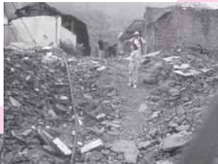
中国・四川地震から1年後に再び現地調査に。地表に断層が現れている
